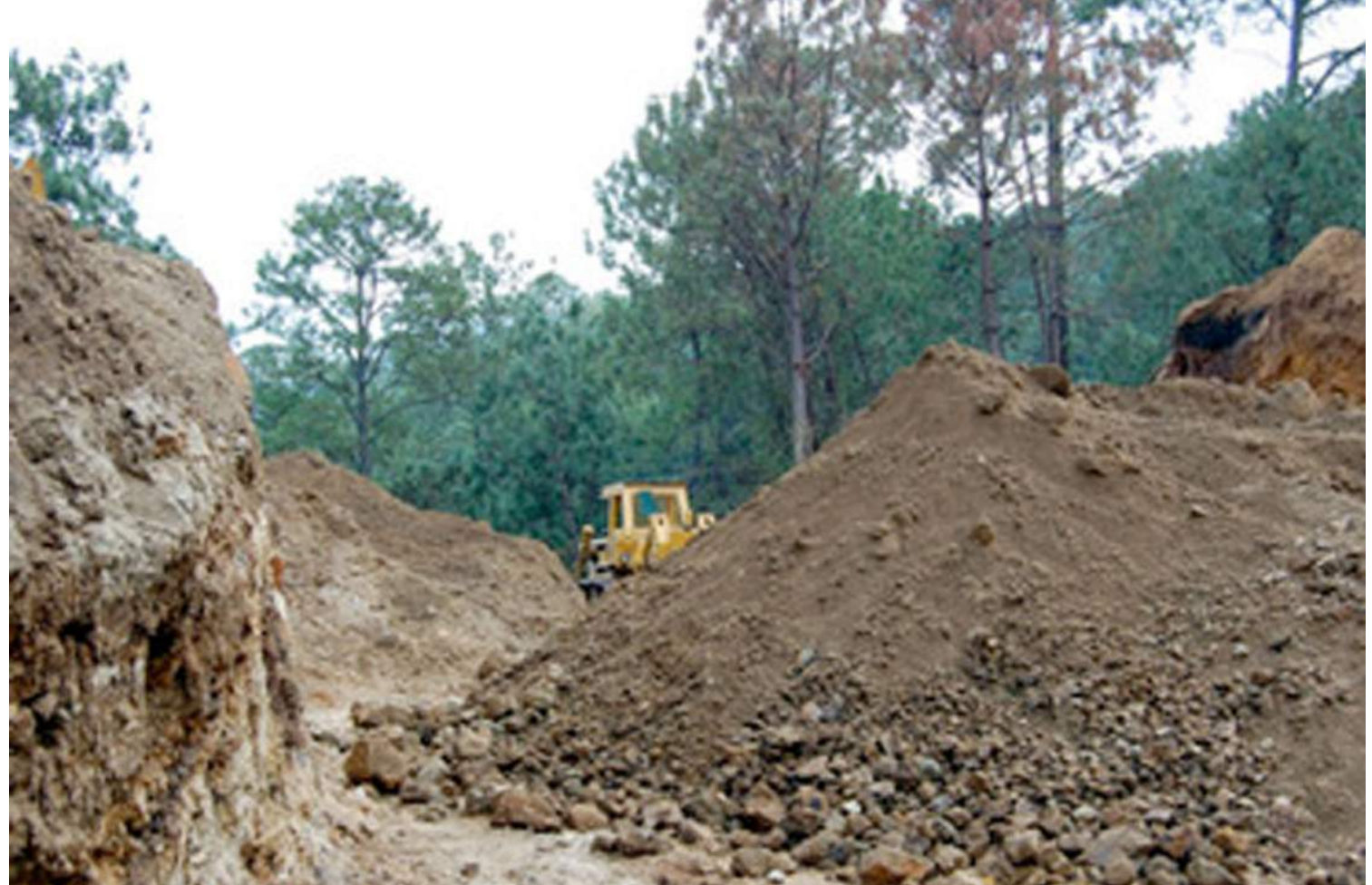
Extracción de hierro a cielo abierto en Tapalpa, Jalisco
